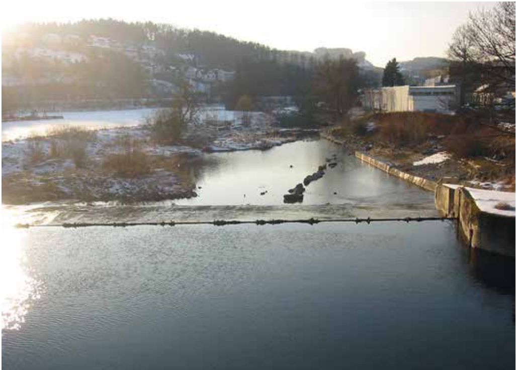
Abb. 2: Die Wasserkraftanlage an der Ruhr
