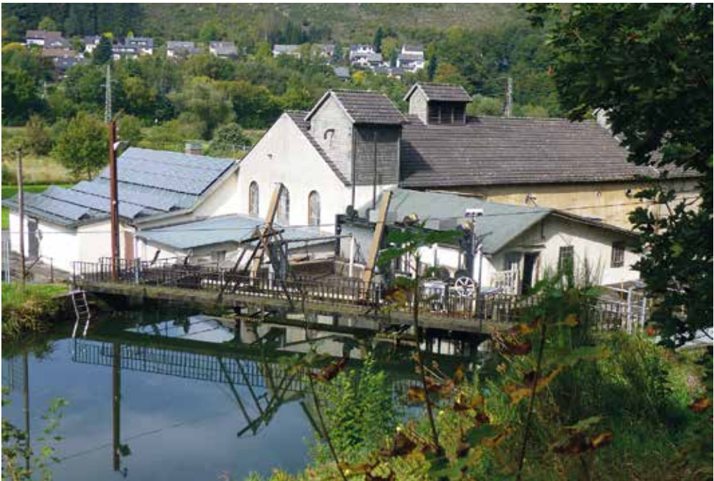
Abb. 1: Die Wasserkraftanlage Linneborn besteht seit 1871.
